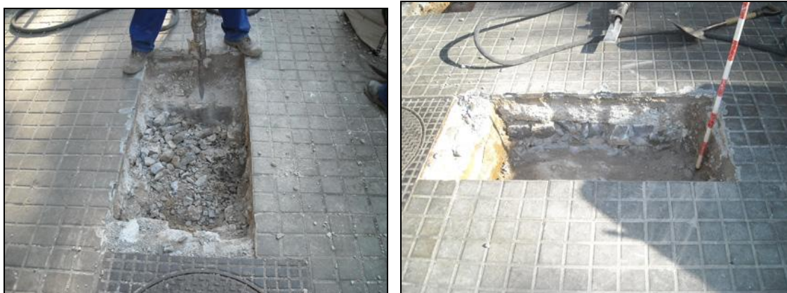
Cala 2 durant el procés de rebaix de les llambordes de la segona fase.
